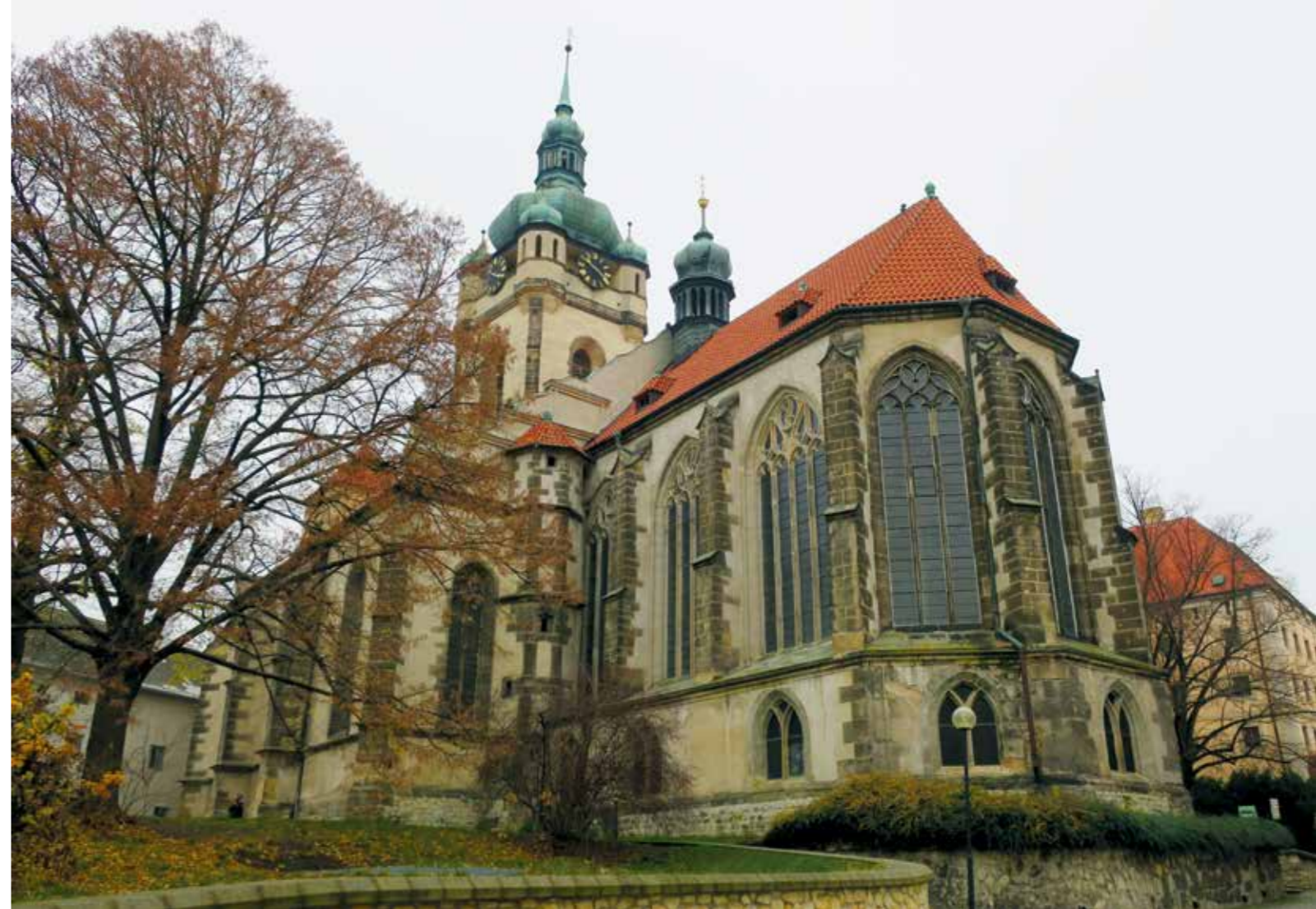
Obr. 1 Současná podoba kostela sv. Petra a Pavla na Mělníce, pohled od jihozápadu, archiv autorky.
