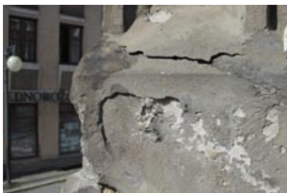
Stav před restaurováním, 2010 – rozpad kamene pod tmely
