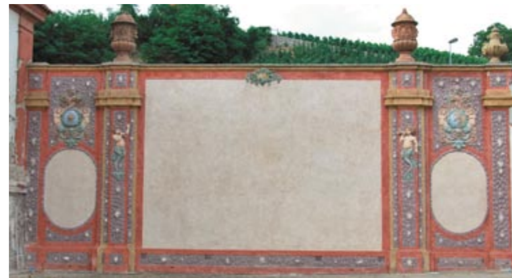
Stav po restaurování a rekonstrukci (foto Václav Špale)
