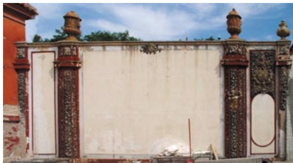
Severní prospekt před restaurováním (foto Jan Brabec)
