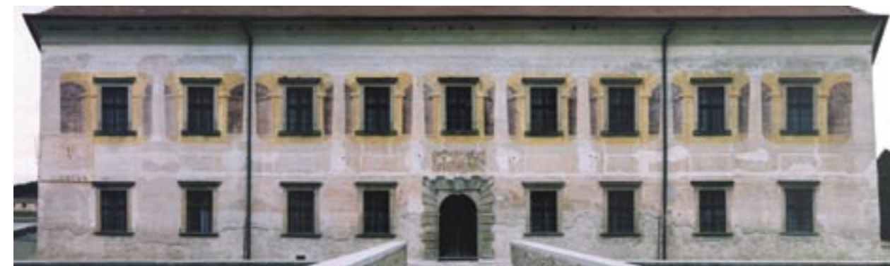
Panorama jižní fasády před restaurováním, 2002 (foto Michal Šrůtek, montáž Matěj Barla)
