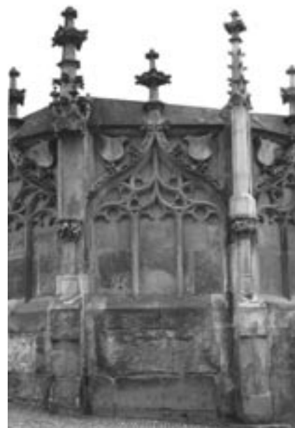
Stav před restaurováním
