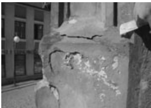
Rozpad kamene pod tmely
