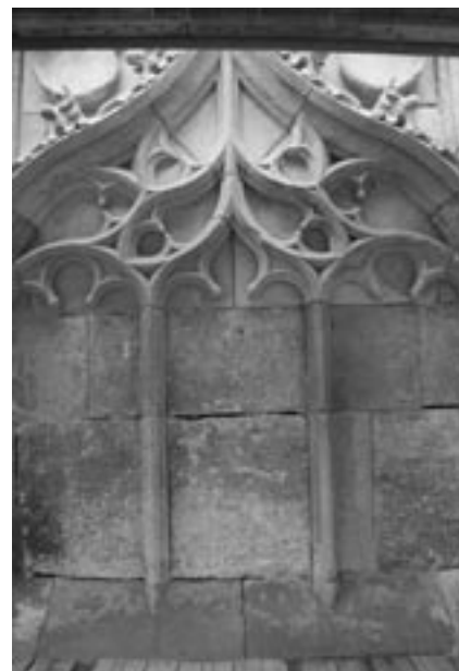
Stav po odstranění vysprávek a po očištění
