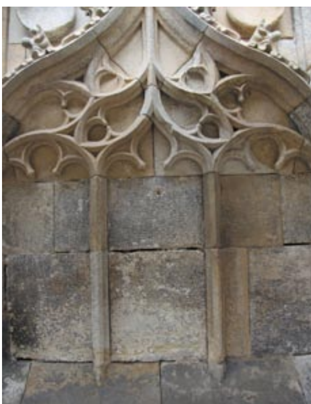
Stav po odstranění vysprávek a po očištění
