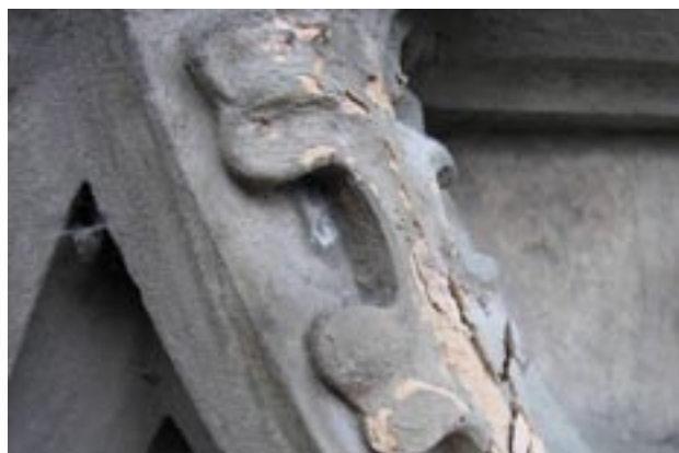
Rozpad kamene pod tmely
