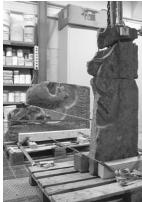
Průběh lepení jednotlivých fragmentů
