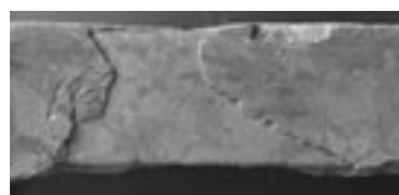
Detaily doplnění chybějících poškozených míst
