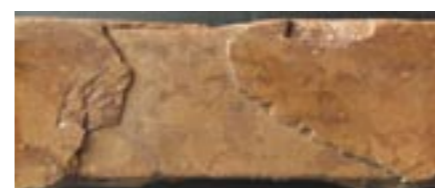
Detaily doplnění chybějících poškozených míst
