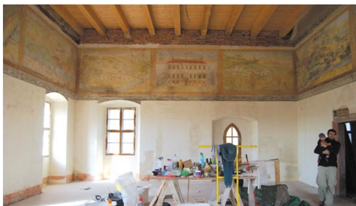
Severní stěna. Nahoře: příprava podkladu před provedením rekonstrukce; dole: stav po rekonstrukci.
