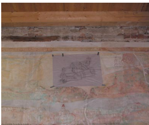
Průběh vytváření hypotetické rekonstrukce na západní stěně.
