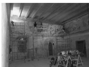
Severní stěna. Příprava podkladu před provedením rekonstrukce.
