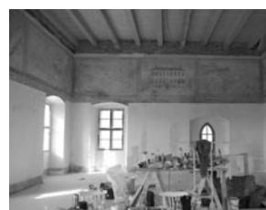
Severní stěna, stav po rekonstrukci.
