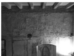
Severní stěna, stav před restaurováním.
