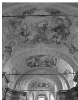
Pohled na klenební pole od západu.
