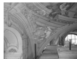
Nejvíce poškozený doběh klenby kněžiště na severovýchodě.
