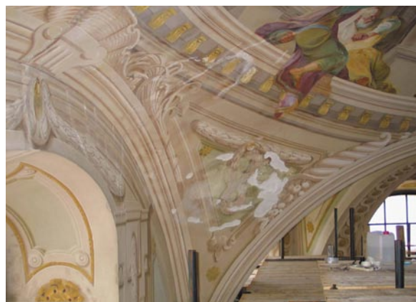
Lesklé fixáže z předchozích zásahů na jižní části 2. klenebního pole v lodi.
