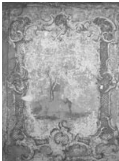
Sál č. 116, část severní stěny, stav po odstranění přemaleb
