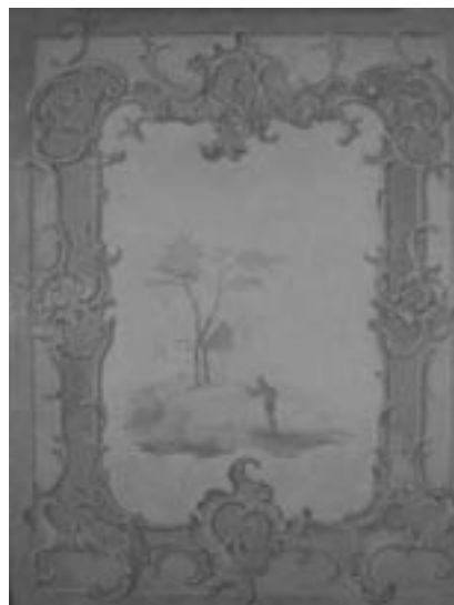
Sál č. 116, část severní stěny, stav po restaurování
