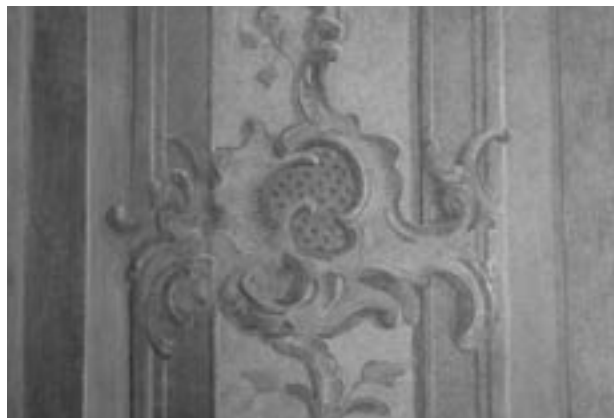
Sál č. 116, severozápadní roh, stav po restaurování
