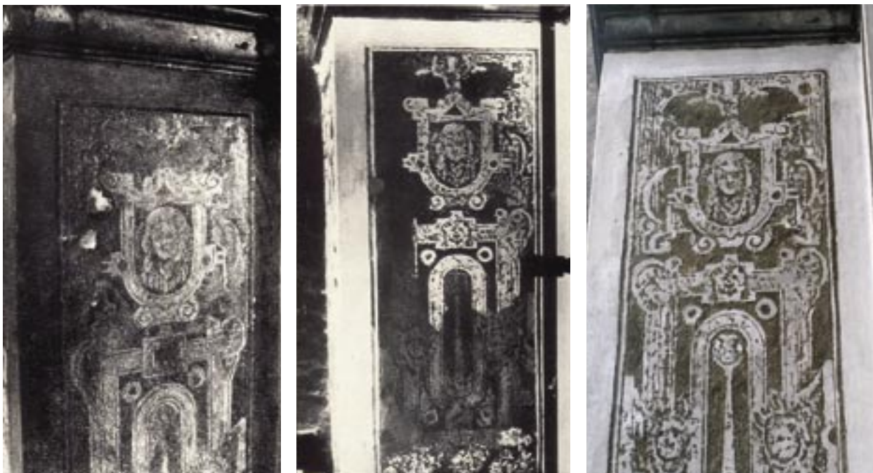
Obrázek 2 – 7. pole, špaleta vlevo – ukázka postupu, při kterém byl originál nejprve přetřen tmavým tónem bez ohledu na původní povrchy intonaka, a pak následovně opět „vyvolán“, fotografie z 50. let 20. stol. a ze současnosti
