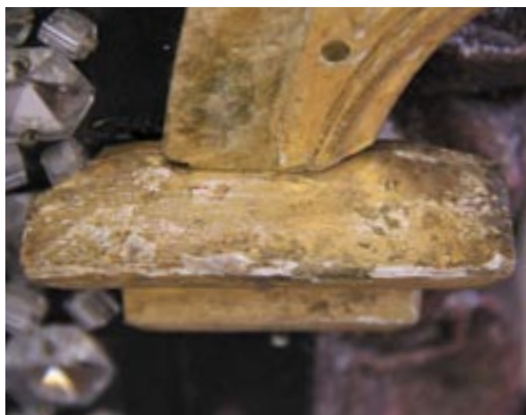
Hlavice levého sloupku po sejmutí bronzového nátěru
