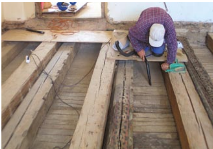
Pracovní snímek čištění meziprostor v místnosti č. 3.5
