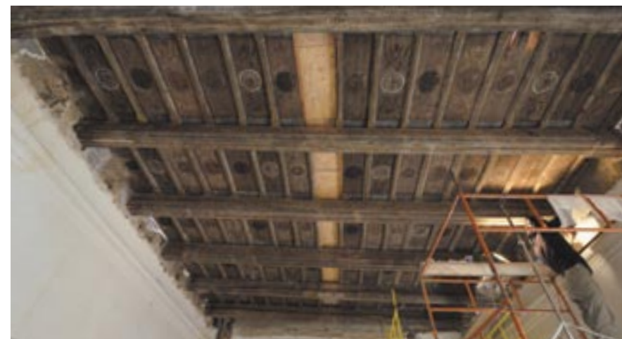
Strop v místnosti č. 2.23, čištění a konzolidace
