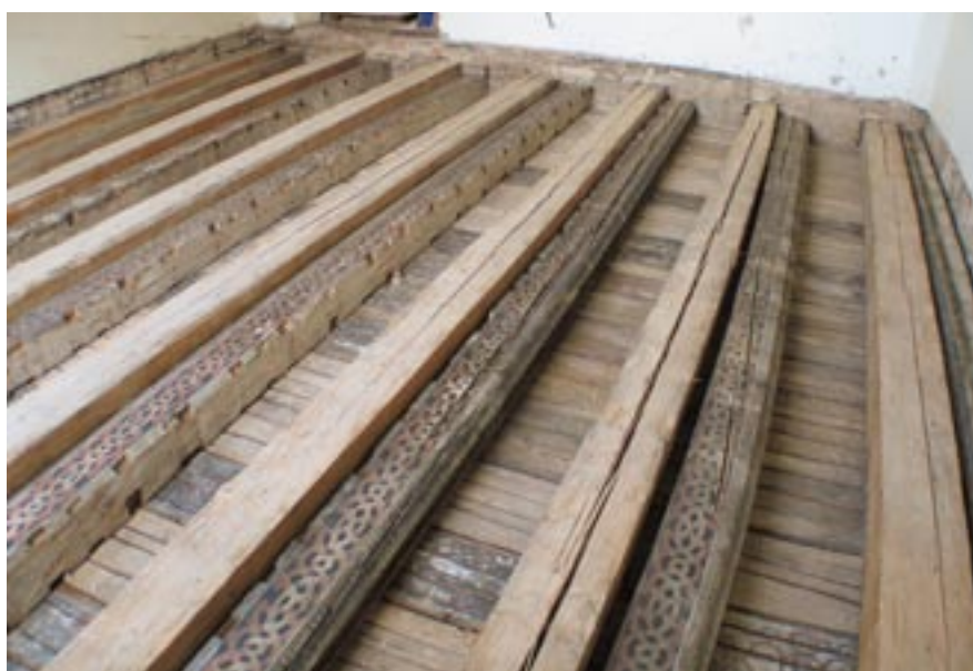
Pracovní snímek podlahy v místnosti č. 3.5 po čištění
