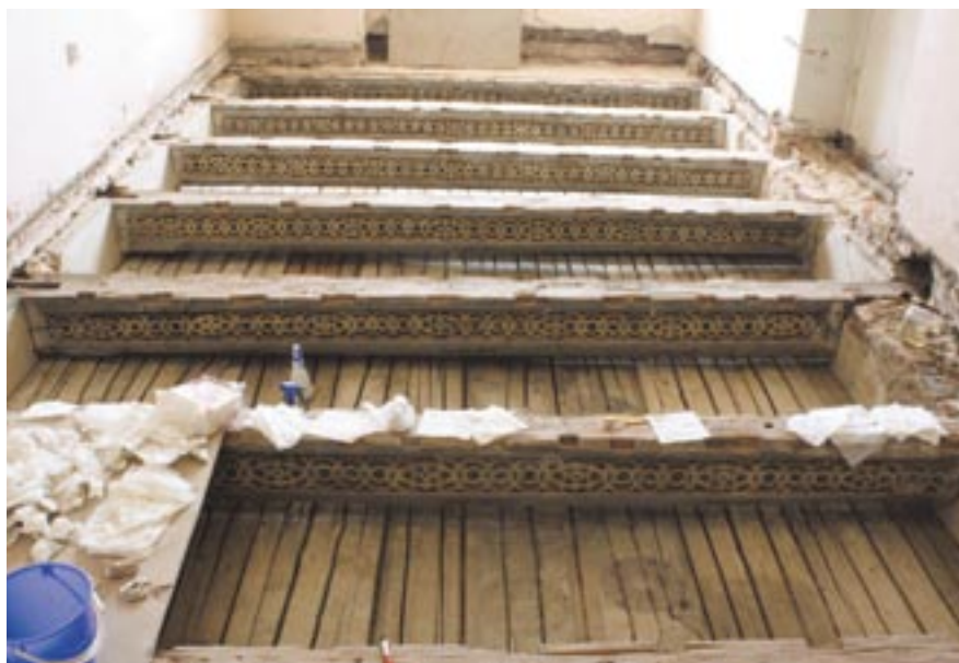
Strop v místnosti č. 2.1, čištění polychromie na trámech
