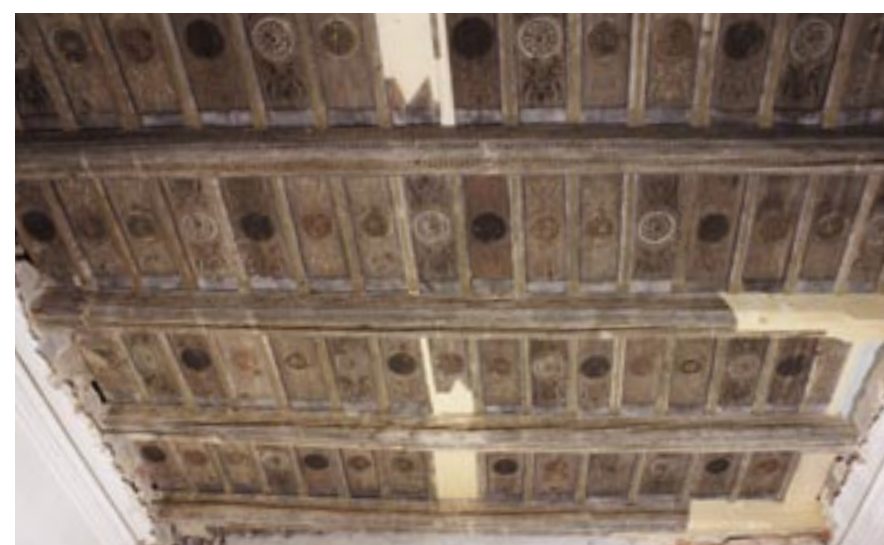
Severní polovina stropu v místnosti č. 2.23 po konzervaci a doplnění novým dřevem
