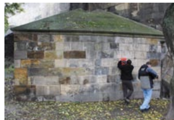
Obr. 8: Karlův most v Praze, měření pozemním penetrujícím radarem SIR – 3000 s anténou 400MHz (foto P. Glaser)
