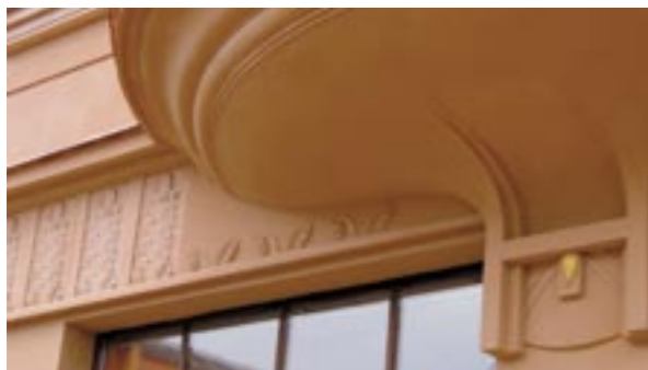
Obr. 17: Dvůr Králové nad Labem, náměstí T. G. Masaryka č. p. 57, detail nově provedené kordonové římsy s výhledem a arkýřové konzoly (foto J. Kašpar)
