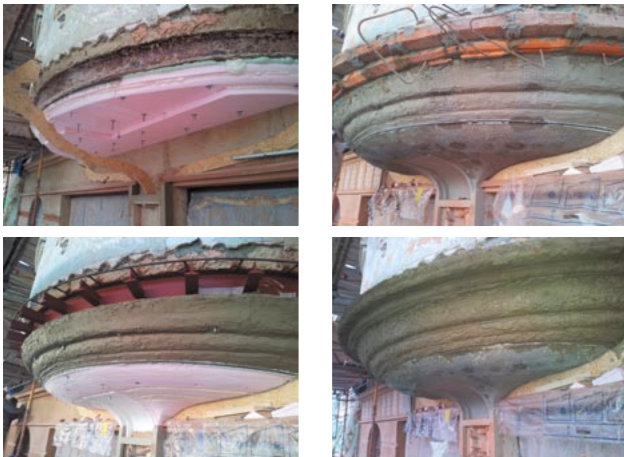
Obr. 16: Dvůr Králové n. L., náměstí T. G. Masaryka č. p. 57, průběh prací na chybějící konzole arkýře (foto J. Kašpar)
