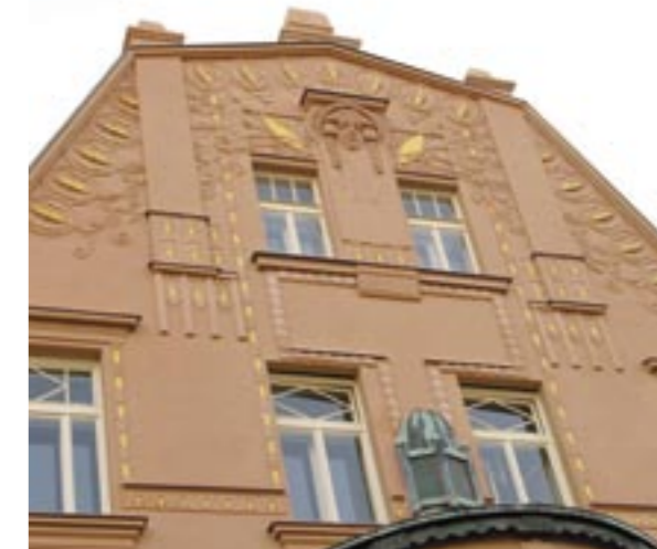
Obr. 19: Detail nově provedené štukové výzdoby štítu (foto M. Kudrnovský)
