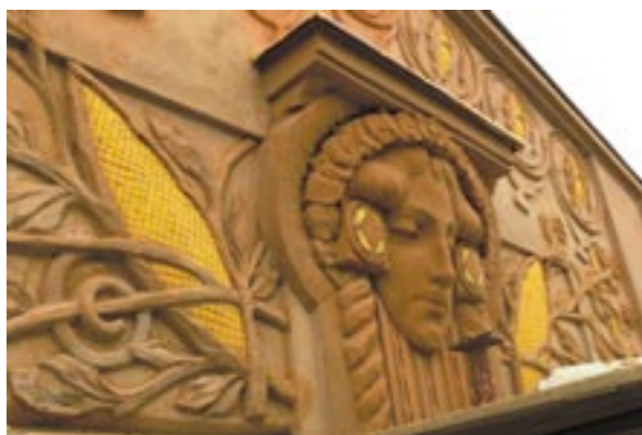
Obr. 10: Dvůr Králové nad Labem, náměstí T. G. Masaryka č. p. 57, průběh modeláže štukové výzdoby štítu (foto M. Kudrnovský)
