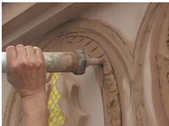
Obr. 9: Dvůr Králové nad Labem, náměstí T. G. Masaryka č. p. 57, průběh modeláže štukové výzdoby štítu (foto J. Kašpar)
