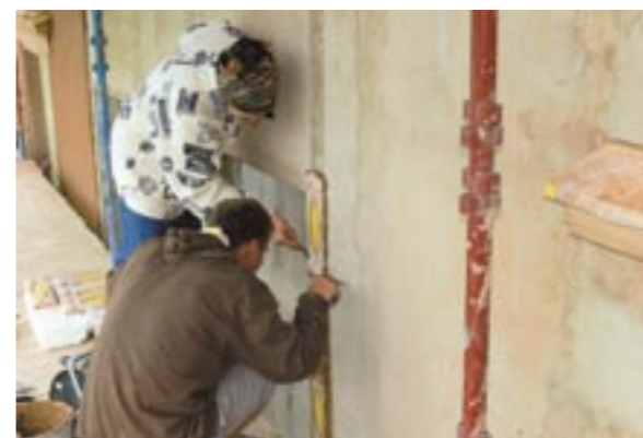
Obr. 14: Dvůr Králové nad Labem, náměstí T. G. Masaryka č. p. 57, osazování dílenských štukových prvků na fasádu (foto J. Kašpar)
