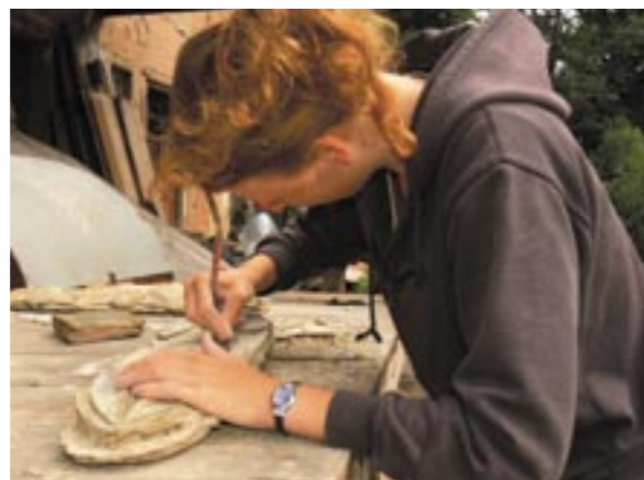
Obr. 11: Dvůr Králové nad Labem, náměstí T. G. Masaryka č. p. 57, čištění původních dílenských prvků od recentních nátěrů (foto J. Kašpar)
