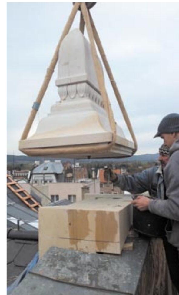
Obr. 15: Dvůr Králové nad Labem, náměstí T. G. Masaryka č. p. 57, osazování pískovcové akroterie (foto J. Kašpar)
