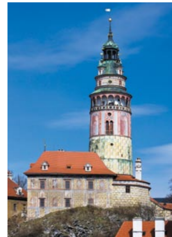
Obr. 3: Hrádek s věží po restaurování, stav v roce 2010 (foto Jaroslav Pouzar)
