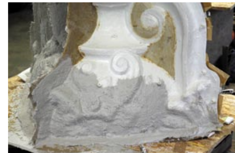
Obr. 3. Postupné nanášení SEWA-crylu se skelnou tkaninou. Foto Josef Čepelka.
