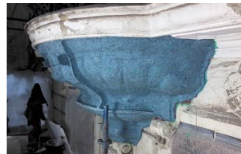
Obr. 8. Dokončený epoxidový kadlub. Foto Josef Čepelka.
