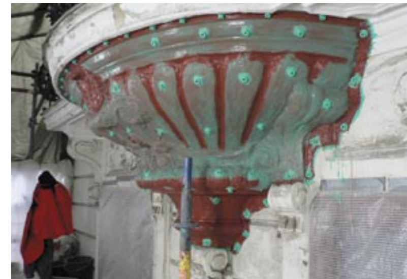
Obr. 7. Silikonový kaučuk před nanesením kadlubu. Foto Josef Čepelka.
