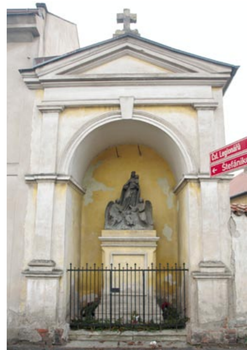
Obř. 1. Sousoší Panny Marie mezi anděly v roce 2008 – stav před započatím stavebních a restaurátorských prací. Foto Jakub Ďoubal.
