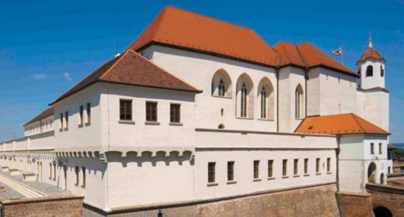
Obr. 1. Hrad Špilberk v Brně po „obnově“ na konci 20. století, pohled na palác. Dostupné z http://www.google.cz/search?q=%C5%A1pilberk&biw=1366&bih=667&source=lnms&tbm=isch&sa=X&sqi=2&ved=0ahUKEwjBzrL65ZTQAhVENxQKHV6QDMUQ_AUIBigB#imgrc=yN_WPlef-niUGWM%3A
