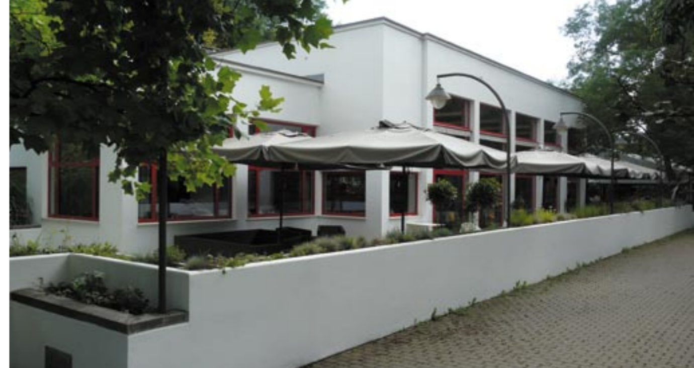
Obr. 2. Zemanova kavárna v Brně, jež stála v letech 1926–64, otevřená jako „volná replika“ Fuchsovy stavby v roce 1995 (stav 2016). Foto Z. Vácha.
