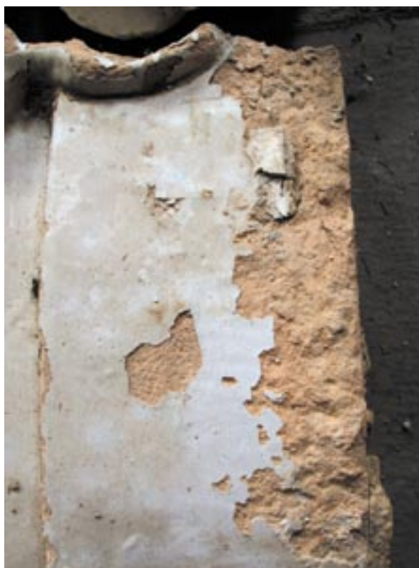
Obr. 5 Poškození střepu a glazury vlhkostí.
