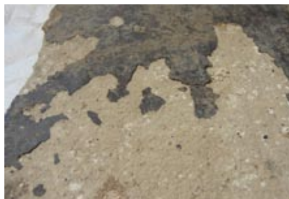
Obr. 12 Všechny zlomky měly narušenou soudržnost střepeku a glazury. Glazura se zvedala a na velkých plochách již zcela chyběla. Na některých zlomcích byla patrná tvrdá krusta ve formě bílých výkvětů.
