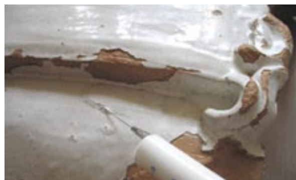
Obr. 6 Aplikace 10% vodního roztoku Dispercollu D2 injektáží pod uvolněnou glazuru.
