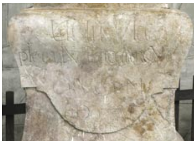
Stav po rekonstrukci písma (před barevným zvýrazněním znaků)
