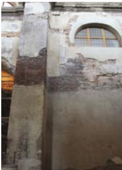
Část vítězného oblouku a severní stěny presbytáře s doplněním nových omítek, stav po konzervaci.
