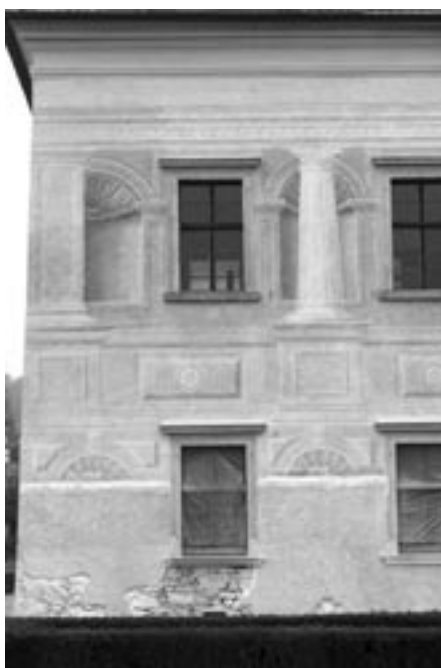
Severní fasáda vily zámku Kratochvíle, stav před a po restaurování (s odsolovacím zábalem)
