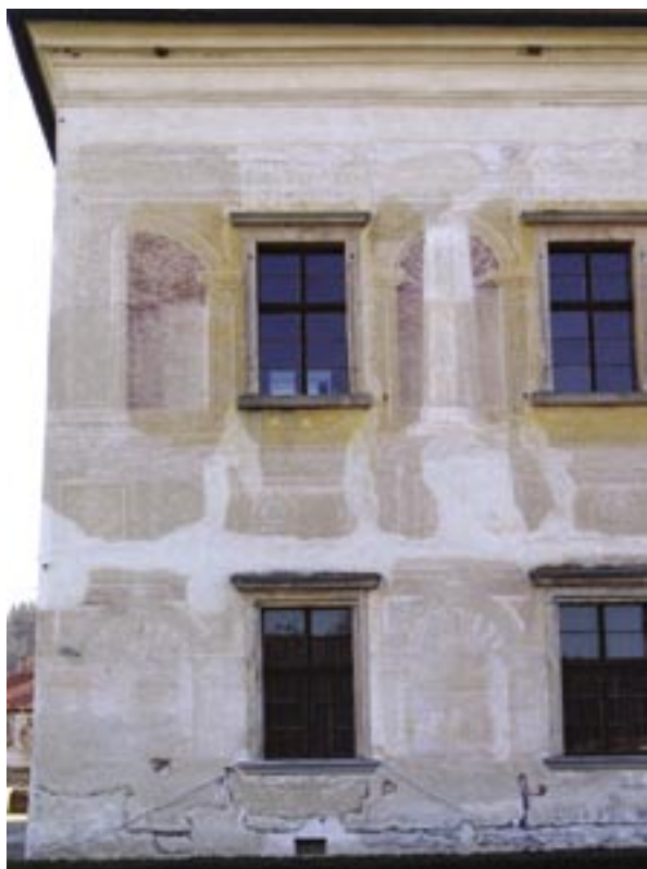
Severní fasáda vily zámku Kratochvíle, stav před
